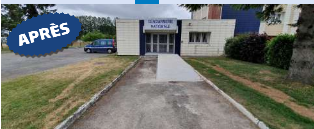
Les rampes d'accès PMR de la gendarmerie
